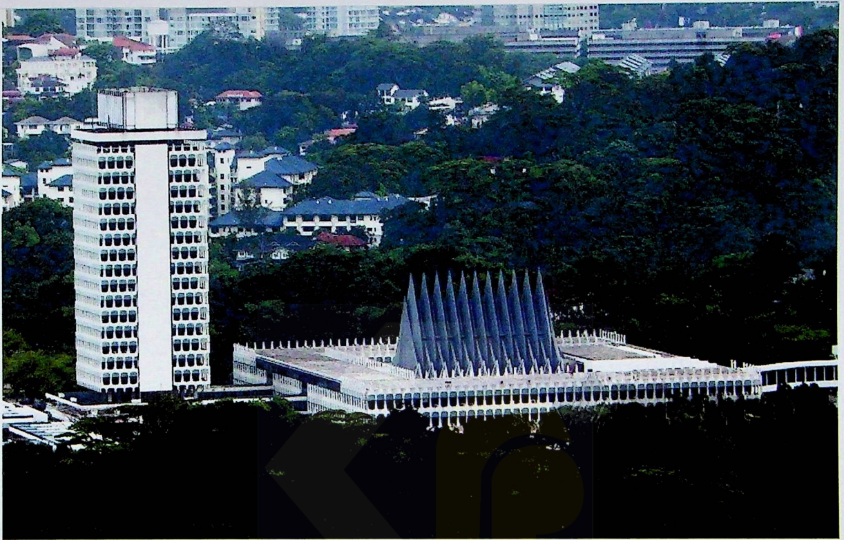
BANGUNAN Parlimen. FOTO arkib NSTP
