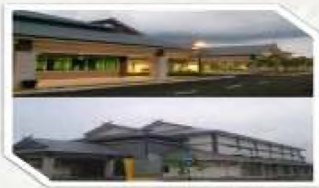
Projek Pembangunan Mini KPDNHEP Kuala Pilah, Negeri Sembilan.
